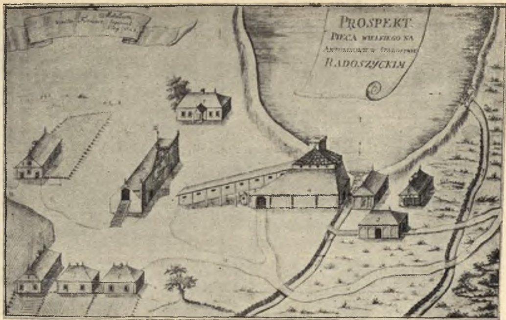
Rys. 3. Zakład wielkopieczowy w Antoninowie, r. 1782.
